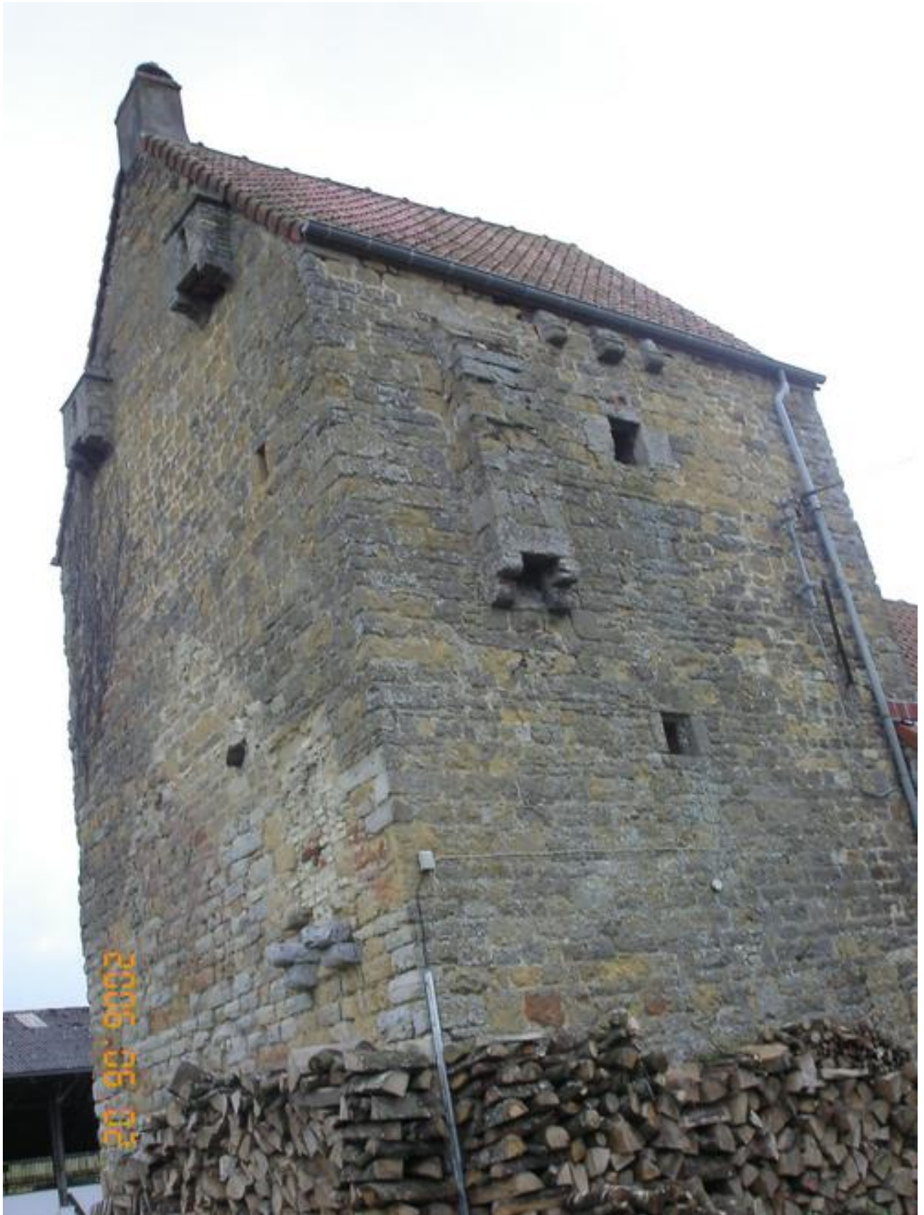
Pignons du corps de logis de la Cense avec leurs machicoulis – Etat actuel
